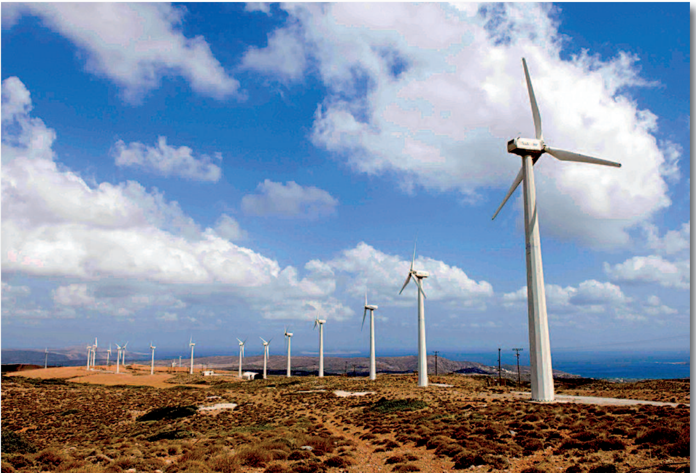
Α/Π Τοπλού Κρήτη (φ. ΔΕΗ)
