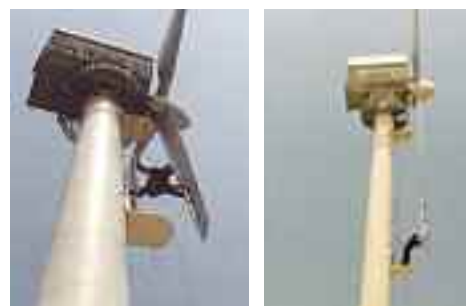
Μισθωτός της ΔΕΗ/ΔΠΝ/ΚΗΜΕ ενώ επισκευάζει το πτερύγιο της Α/Γ σε ύψος 20m από το έδαφος.
